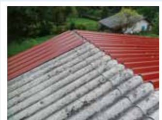
Sanierung Wellplattendach
