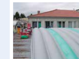
Sanierung gewölbte Profile
