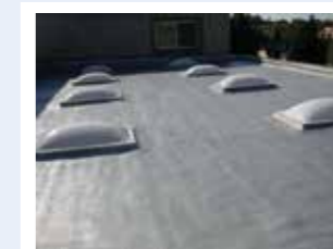
Sanierung PU-Schaumdach
