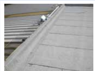
Sanierung mit Plastomernbahnen
