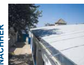
Welleternit mit Wärmedämmung
