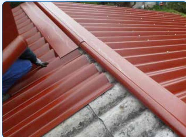
Nach erfolgter Reinigung des Daches (Moos und ähnliches entfernen) werden kleinere Reparaturen in der Fläche durchgeführt. Eventuell lockere Schrauben in den vorhandenen Wellplatten werden wieder angezogen/ingeschraubt. Stahlprofile, Scanwell Sanierungswelle wird geliefert und montiert.
