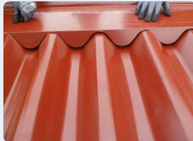
An- und Abschlüsse abdichten bzw. neue Einfassungen aus Blech anfertigen. Neue Firstbleche und soweit erforderlich neue Rand- und Traufenbleche anfertigen und montieren.
