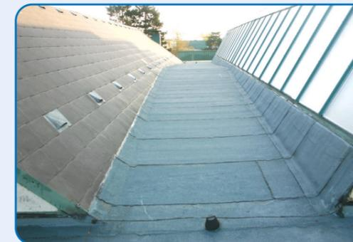
Eine 4 oder 5 mm starke vliesamierte Abdichtungsbahn, welche für zusätzlichen UV-Schutz mit Schieferabstreifung versehen ist, wird als zweite Dachhaut verlegt.
