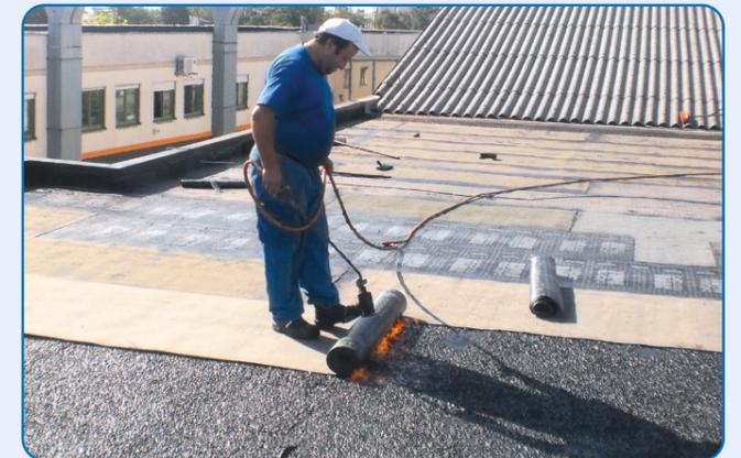
Die erste Lage Dachhaut wird mit 4 mm starken Abdichtungsbahnen im Flämmverfahren verlegt.
