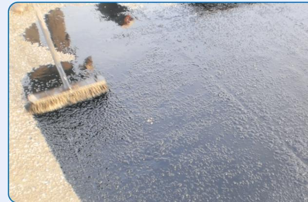
Die Fläche wird mit Voranstrich, als Staubbinder und Haftbrücke versehen.
