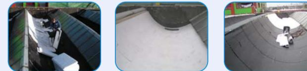
Zuletzt wird eine neue 1. Lage Dachhaut über die Wärmedämmung verlegt und an der Oberkante an der Nagelbohle zusätzlich befestigt.
